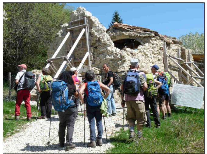
La chiesa di Santa Maria in Pantano danneggiata dal sisma
