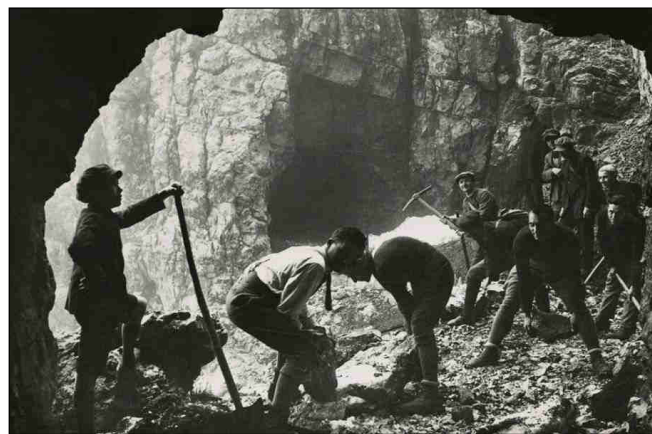
Manutenzione della strada (Archivio CAI Schio)
