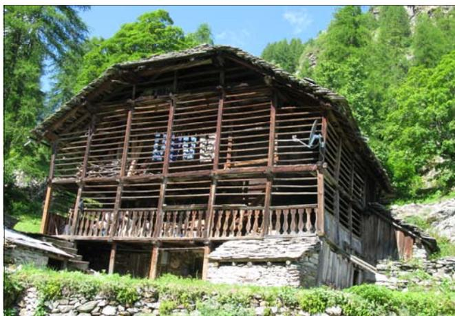
quasi quadrata realizzata in pietrame a secco, si sovrappone una cellula di legno a due piani, circondata su tre o quattro lati da una balconata delimitata da montanti verticali che sostengono il tetto a due falde ricoperto di lastre di pietra.
