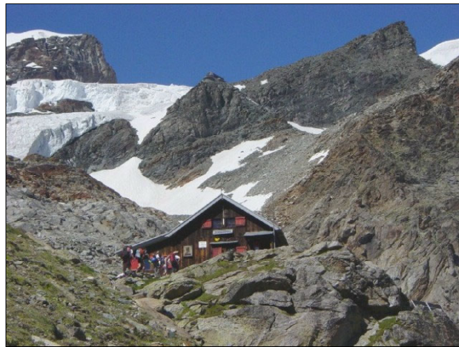
Il Rifugio Mezzalama in estate
